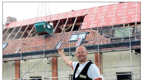
Dachdeckermeister Dirk Wiegel freut sich auf den planmäßigen Fortgang bei der Dachsanierung.
